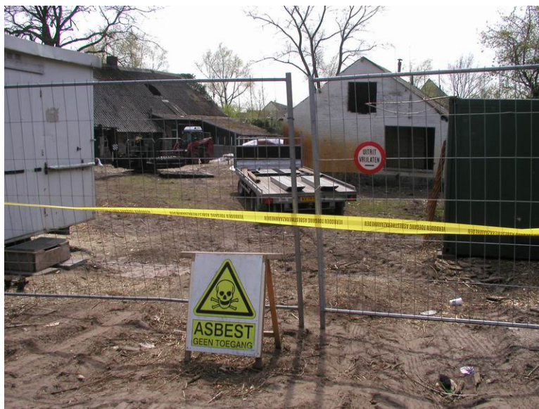
Figuur 17: Afscherming van een asbestverdachte locatie
