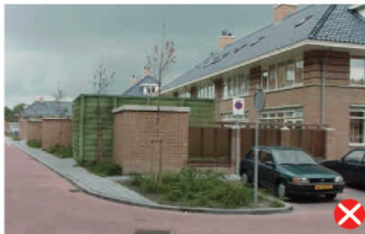
niet passend door afwijkend materiaal- en kleur gebruik
