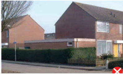
zijaanbouw te dicht bij voorgevelrooilijn
