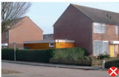
niet passend door afwijkend materiaalgebruik
