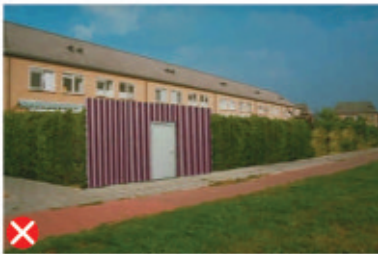
niet passend door gebruik damwand-profiel
