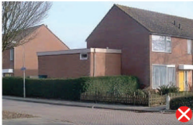
zijaanbouw te hoog
